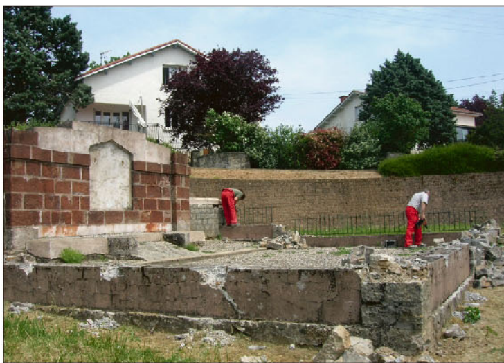
Démolition du monument provisoire qui datait de 1950.
